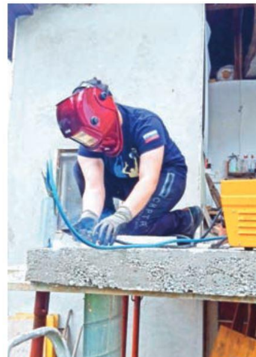
Pri varjenju konstrukcije za ograjo
